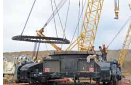
Монтаж экскаваторов отечественного и импортного производства
